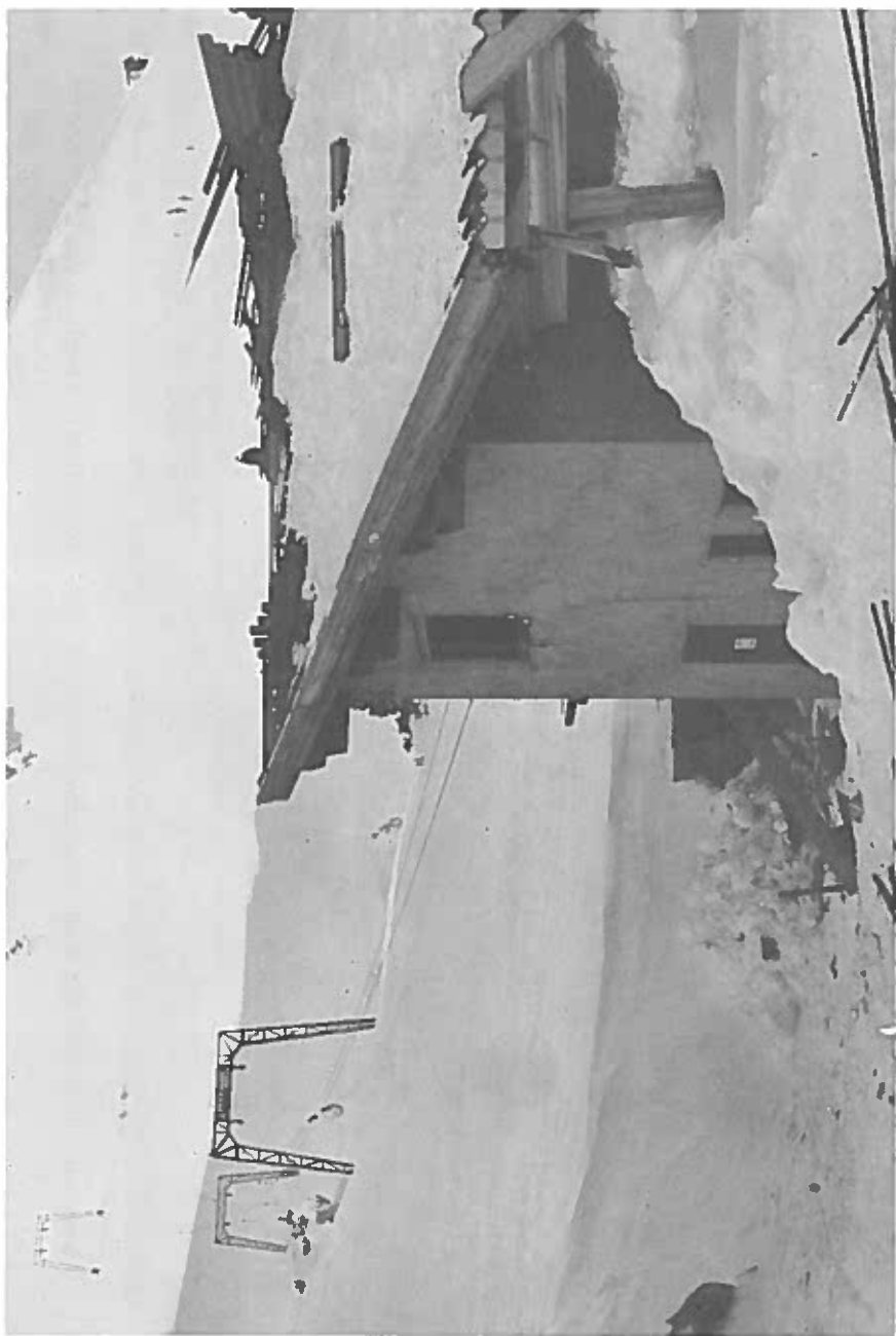
Lawinenabgang unter der Herbstspitze (zu Nr. 75). Schwere Beschädigung der Talstation der 2. Sektion des Gamsleitenliftes. Foto: Merwald, FBVA
